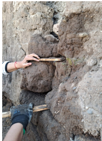
Figura 6. Estación de acciones de consolidación – reintegraciones volumétricas con tierra amasada y refuerzos con madera. Actividades realizadas durante el taller “Conservación Sostenible de Sistemas Constructivos Tradicionales de tierra en el Bajío”, llevado a cabo en el municipio de Valle de Santiago, Gto., febrero de 2023, en colaboración con el Colegio de Arquitectos del Estado de Guanajuato (Cruz y Guerrero, 2023)
