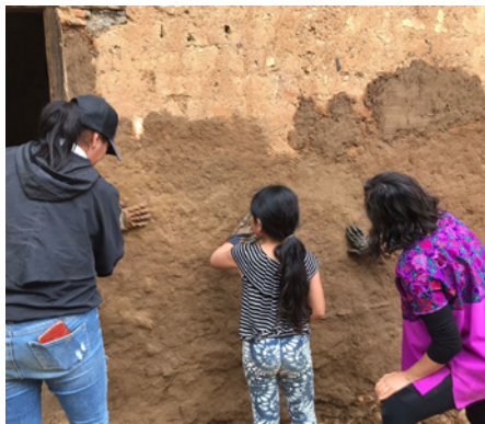
Figura 8. Arriba: Estación de reintegración volumétrica con adobes. Abajo: Estación de integración de recubrimientos de tierra. Actividades realizadas durante el taller “Construir y restaurar con tierra”, en colaboración con la Unidad de Gestión del Centro Histórico de la ciudad de Guanajuato, Centro INAH Guanajuato y el Instituto Estatal de la Cultura, en la Sierra de Santa Rosa, Guanajuato, en agosto de 2023. Fuente: Guerrero, 2023.
