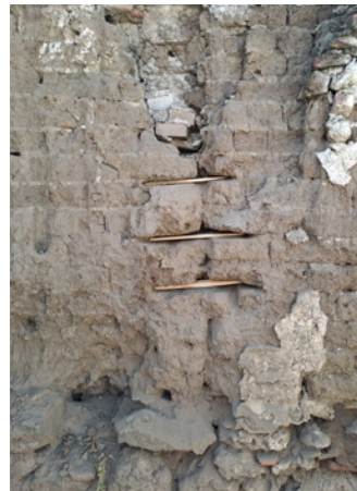
Figura 6. Estación de acciones de consolidación – reintegraciones volumétricas con tierra amasada y refuerzos con madera. Actividades realizadas durante el taller “Conservación Sostenible de Sistemas Constructivos Tradicionales de tierra en el Bajío”, llevado a cabo en el municipio de Valle de Santiago, Gto., febrero de 2023, en colaboración con el Colegio de Arquitectos del Estado de Guanajuato (Cruz y Guerrero, 2023)
