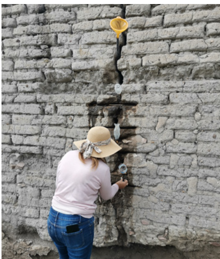
Figura 7. Estación de reintegración volumétrica, cocido e inyección de grietas. Fuente: Cruz, 2024.
