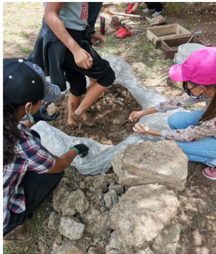
Figura 5. Estación de acciones preliminares: recuperación, limpieza y reutilización de la tierra del sitio, producto de la erosión, disgregación o colapsos de muros y otros elementos constructivos, para producir nuevamente adobes y mezclas de tierra amasada para hacer las intervenciones necesarias. Actividades realizadas durante el taller de “Restauración de arquitectura de tierra”, llevado a cabo en el municipio de Guanajuato, Gto., en julio de 2022, en colaboración con la Universidad de Guanajuato. Fuente: Cruz, 2022.
