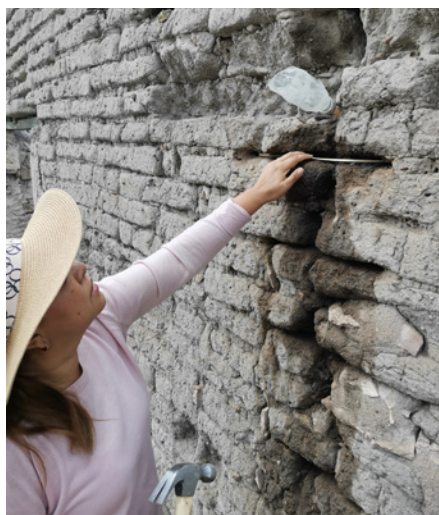
Figura 7. Estación de reintegración volumétrica, cocido e inyección de grietas. Fuente: Cruz, 2024.
