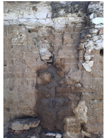
Figura 6. Estación de acciones de consolidación – reintegraciones volumétricas con tierra amasada y refuerzos con madera. Actividades realizadas durante el taller “Conservación Sostenible de Sistemas Constructivos Tradicionales de tierra en el Bajío”, llevado a cabo en el municipio de Valle de Santiago, Gto., febrero de 2023, en colaboración con el Colegio de Arquitectos del Estado de Guanajuato (Cruz y Guerrero, 2023)
