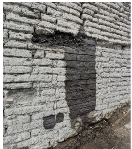
Figura 6. Estación de acciones de consolidación – reintegraciones volumétricas con tierra amasada y refuerzos con madera. Actividades realizadas durante el taller “Conservación Sostenible de Sistemas Constructivos Tradicionales de tierra en el Bajío”, llevado a cabo en el municipio de Valle de Santiago, Gto., febrero de 2023, en colaboración con el Colegio de Arquitectos del Estado de Guanajuato (Cruz y Guerrero, 2023)
