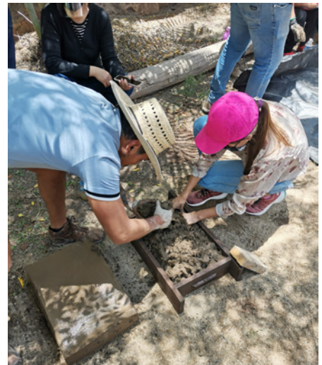
Figura 5. Estación de acciones preliminares: recuperación, limpieza y reutilización de la tierra del sitio, producto de la erosión, disgregación o colapsos de muros y otros elementos constructivos, para producir nuevamente adobes y mezclas de tierra amasada para hacer las intervenciones necesarias. Actividades realizadas durante el taller de “Restauración de arquitectura de tierra”, llevado a cabo en el municipio de Guanajuato, Gto., en julio de 2022, en colaboración con la Universidad de Guanajuato. Fuente: Cruz, 2022.
