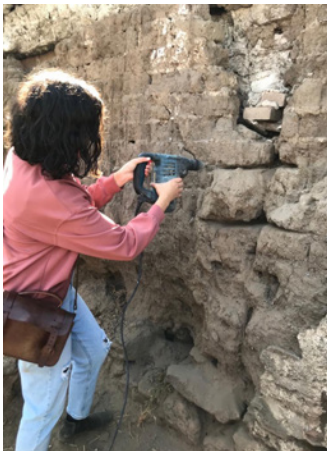
Figura 6. Estación de acciones de consolidación – reintegraciones volumétricas con tierra amasada y refuerzos con madera. Actividades realizadas durante el taller “Conservación Sostenible de Sistemas Constructivos Tradicionales de tierra en el Bajío”, llevado a cabo en el municipio de Valle de Santiago, Gto., febrero de 2023, en colaboración con el Colegio de Arquitectos del Estado de Guanajuato (Cruz y Guerrero, 2023)
