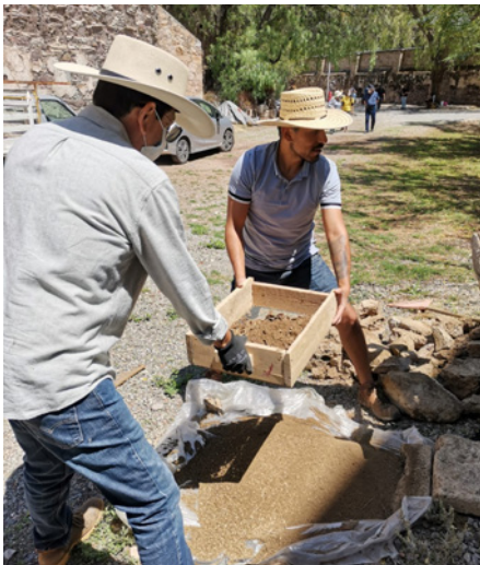
Figura 5. Estación de acciones preliminares: recuperación, limpieza y reutilización de la tierra del sitio, producto de la erosión, disgregación o colapsos de muros y otros elementos constructivos, para producir nuevamente adobes y mezclas de tierra amasada para hacer las intervenciones necesarias. Actividades realizadas durante el taller de “Restauración de arquitectura de tierra”, llevado a cabo en el municipio de Guanajuato, Gto., en julio de 2022, en colaboración con la Universidad de Guanajuato. Fuente: Cruz, 2022.
