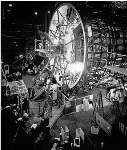
Figura 31. Construcción de la centrífugadora de 30 toneladas para las escenas de la Estación Espacial.
