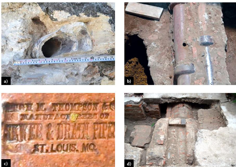
**Figura 9.** Detalle de los bajantes pluviales y sistema de drenaje localizados en la Aduana. a) Evidencia de bajantes pluviales intramuros, b) bajantes y caños de barro vidriado bajo los pisos de la aduana hacia el canal colector central, c) marca de la casa fabricante de los tubos, d) canal colector con bóveda de cañón corrido con salida hacia el río Grijalva. Fotografías: Geiser Martín Medina.
