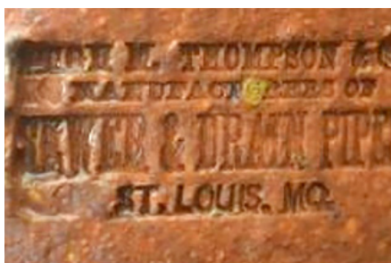
Figura 9. Detalle de los bajantes pluviales y sistema de drenaje localizados en la Aduana. a) Evidencia de bajantes pluviales intramuros, b) bajantes y caños de barro vidriado bajo los pisos de la aduana hacia el canal colector central, c) marca de la casa fabricante de los tubos, d) canal colector con bóveda de cañón corrido con salida hacia el río Grijalva. Fotografías: Geiser Martín Medina.
