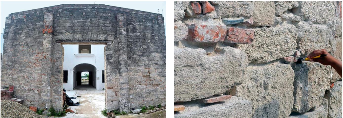
**Figura 5.** Detalle del sistema constructivo de la Aduana. Izquierda: paramento oriente del patio interior que muestra los bloques de conchuela. Derecha: detalle de los bloques de conchuela y elementos de ladrillo, mosaico y teja empleados en las juntas a manera de cuñas. Fotografías: Geiser Martín Medina.
