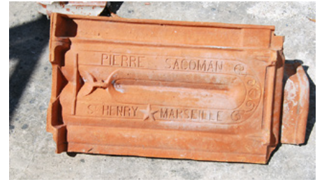
Figura 7. Detalle de las tejas localizadas en la Aduana. a) Separación de elementos por casa de fabricación, b) Teja Fabrique La Plata (Ancla), c) y d) Dos tipos de teja Pierre Sacoman (estrella). Fotografías: Geiser Martín Medina.
