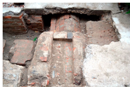
Figura 9. Detalle de los bajantes pluviales y sistema de drenaje localizados en la Aduana. a) Evidencia de bajantes pluviales intramuros, b) bajantes y caños de barro vidriado bajo los pisos de la aduana hacia el canal colector central, c) marca de la casa fabricante de los tubos, d) canal colector con bóveda de cañón corrido con salida hacia el río Grijalva. Fotografías: Geiser Martín Medina.
