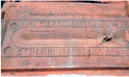
Figura 7. Detalle de las tejas localizadas en la Aduana. a) Separación de elementos por casa de fabricación, b) Teja Fabrique La Plata (Ancla), c) y d) Dos tipos de teja Pierre Sacoman (estrella). Fotografías: Geiser Martín Medina.
