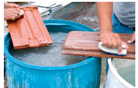
Figura 8. Actividad de lavado de tejas para su almacenamiento. Fotografía: Geiser Martín Medina.
