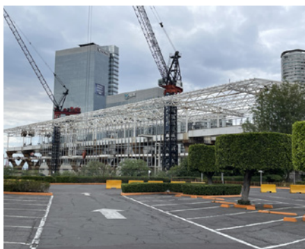
Figura 1. Estación Santa Fe del tren Interurbano México-Toluca. Ya se inauguró un tramo y en 2024 se completará la obra, incluido el tramo a Santa Fe. Fotografía: Bernardo Navarro, 2023.
