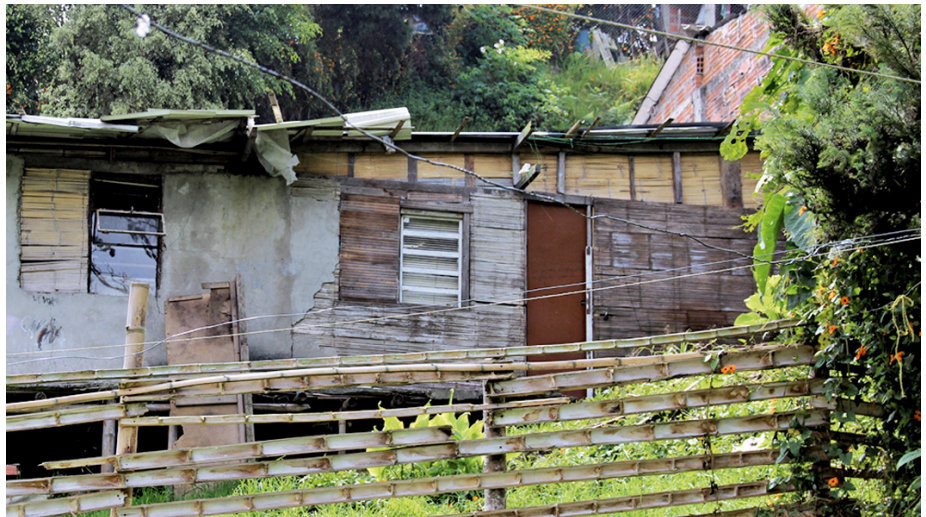
Figuras 13. Vivienda de bajareque con recubrimientos de cemento. Fotografía: Alleck J. González.
