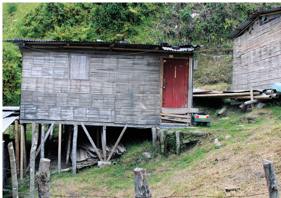
Figura 8. Vivienda tipo “palafito” en el barrio Chachafruto en Manizales, hecha con estructura y muros de guadua. Fotografía: Alleck J. González.
