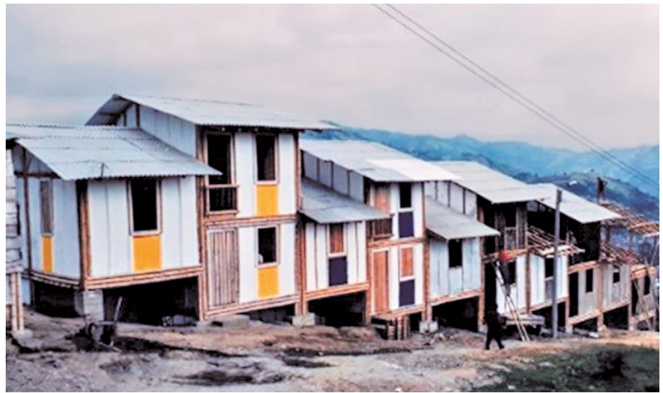
Figura 4. Viviendas contemporáneas con estructura de bambú y muros de bajareque encementado en Manizales, Colombia. Fotografía: Arq. Gilberto Flórez.
