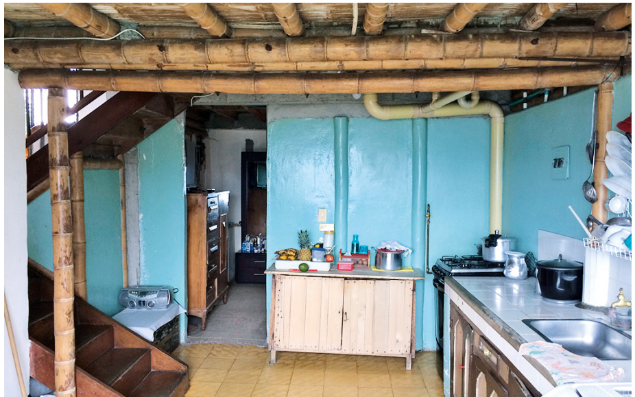
Figura 14. La flexibilidad del sistema constructivo de bajareque permite adecuaciones espaciales. Adaptación de un dormitorio en el sótano junto a la cocina preexistente. Fotografía: Alleck J. González.
