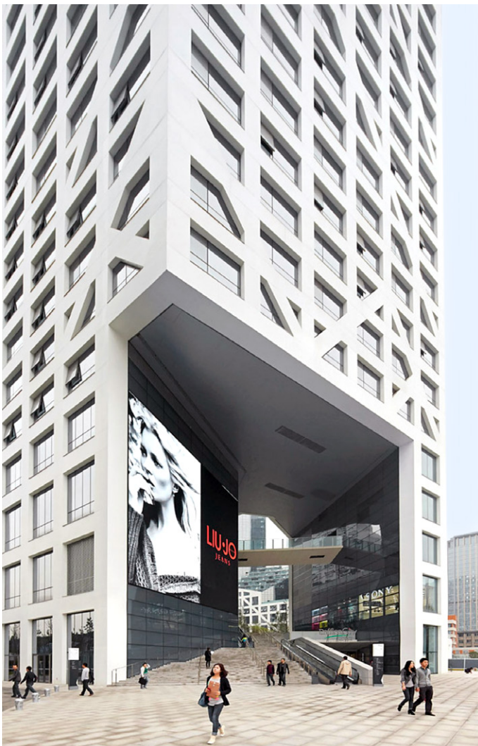
Figura 24. Puerta o sitio de ingreso al Sliced Porosity Block . Fuente: https://acortar.link/6SNebF
