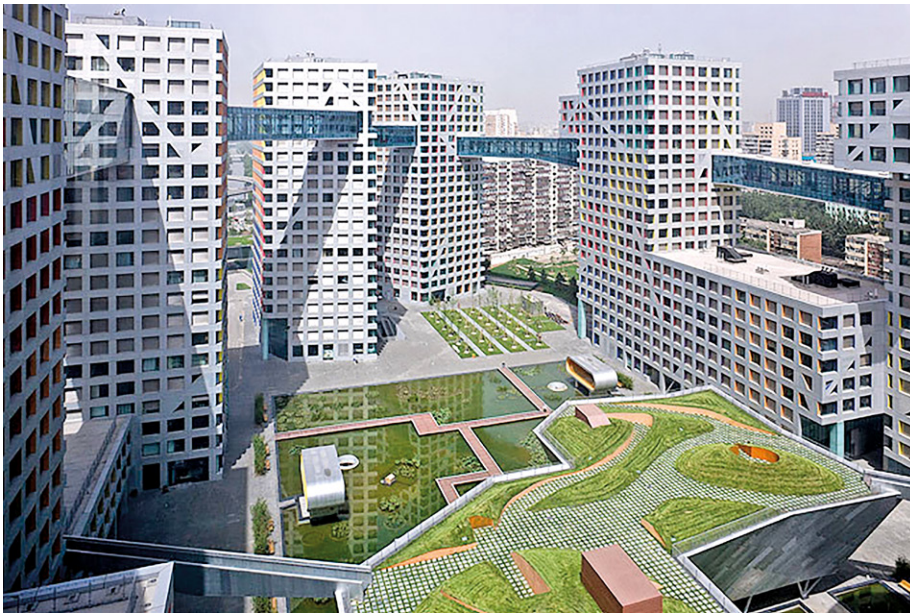
Figura 1. Panorámica del interior del conjunto Linked Hybrid . Fuente: https://acortar.link/XW1Mew .
