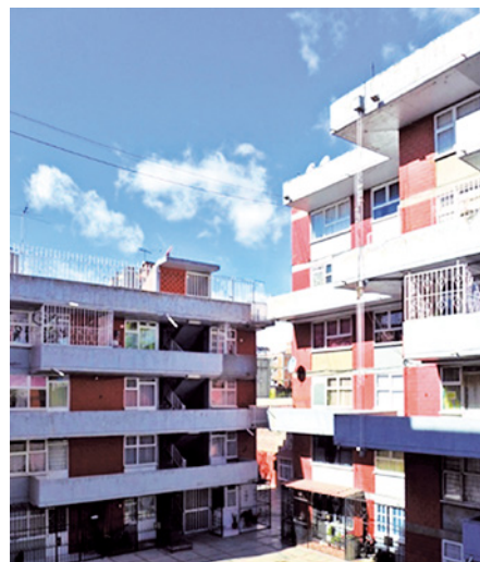
Figura 24. Unidad Habitacional Cohuatlan. Fotografía: Onnis Luque, 2016.
