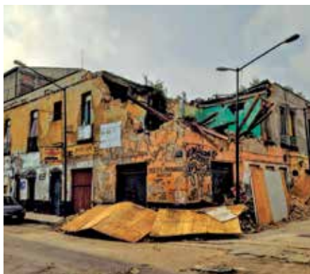
Figura 28. Colapso ¿parcial? Ubicación: Mina 16, esquina Plaza 2 de Abril, colonia Guerrero. Causa: Falta de resistencia y rigidez en elementos estructurales en el techo –diafragma–, haciendo uso de vigas de madera, que soportaban la cubierta, la edad del edificio y la falta de mantenimiento adecuado.
