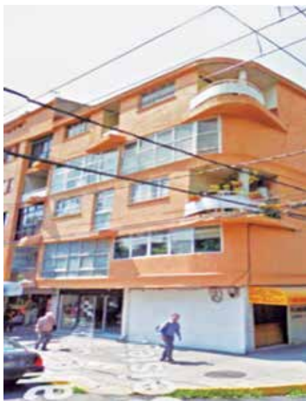
Figura 30. Colapso ¿Parcial? Ubicación: Concepción Béistegui esquina Yácatas, colonia Narvarte Poniente. Causas: edificio en esquina. Las causas por las que se dañó el edificio fueron su ubicación en la esquina, la falta de continuidad, dimensionamiento y resistencia de los elementos estructurales, y que estos fueron diferentes en los muros de colindancia (ciegos) e insuficientes para absorber el esfuerzo del sismo. Otra razón probable es la edad del edificio y un mantenimiento inadecuado.
