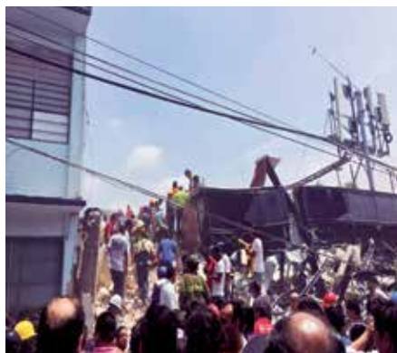
Figura 29. Colapso total. Ubicación: Bolívar 168, colonia Obrera, Ciudad de México. Causas: cambio de uso. La principal causa del colapso fue la utilización de un edificio con una finalidad distinta a aquella para la que fue proyectado y construido originalmente. Sobrepeso a la estructura debido a la maquinaria colocada que rebasó la capacidad de carga “viva” calculada originalmente.
