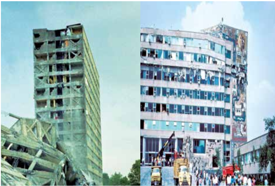
Figuras 18 y 19. Edificaciones que sufrieron colapso ¿parcial? durante los sismos de septiembre de 1985. Fuente: http://vivirtlatelolco.blogspot.com .
