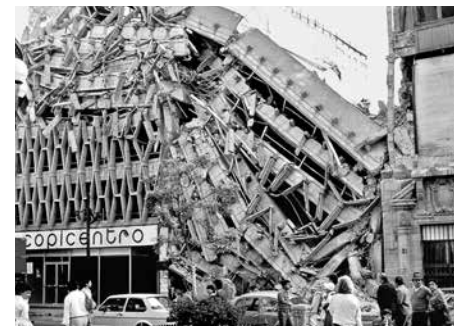
Figuras 14 a 17. Edificaciones que sufrieron colapso ¿parcial? durante los sismos de septiembre de 1985. Fuente: www.eleconomista.com.mx , candidmanmx.wordpress.com , http://jornadabc.mx .
