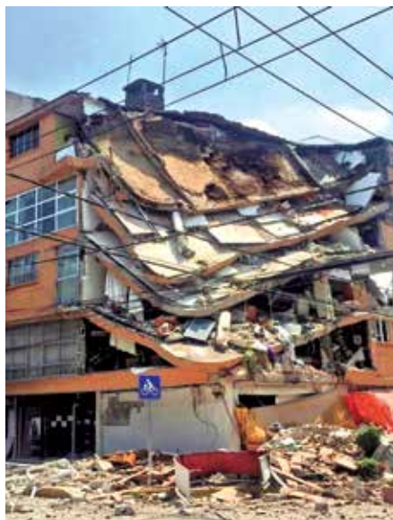
Figura 30. Colapso ¿Parcial? Ubicación: Concepción Béistegui esquina Yácatas, colonia Narvarte Poniente. Causas: edificio en esquina. Las causas por las que se dañó el edificio fueron su ubicación en la esquina, la falta de continuidad, dimensionamiento y resistencia de los elementos estructurales, y que estos fueron diferentes en los muros de colindancia (ciegos) e insuficientes para absorber el esfuerzo del sismo. Otra razón probable es la edad del edificio y un mantenimiento inadecuado.
