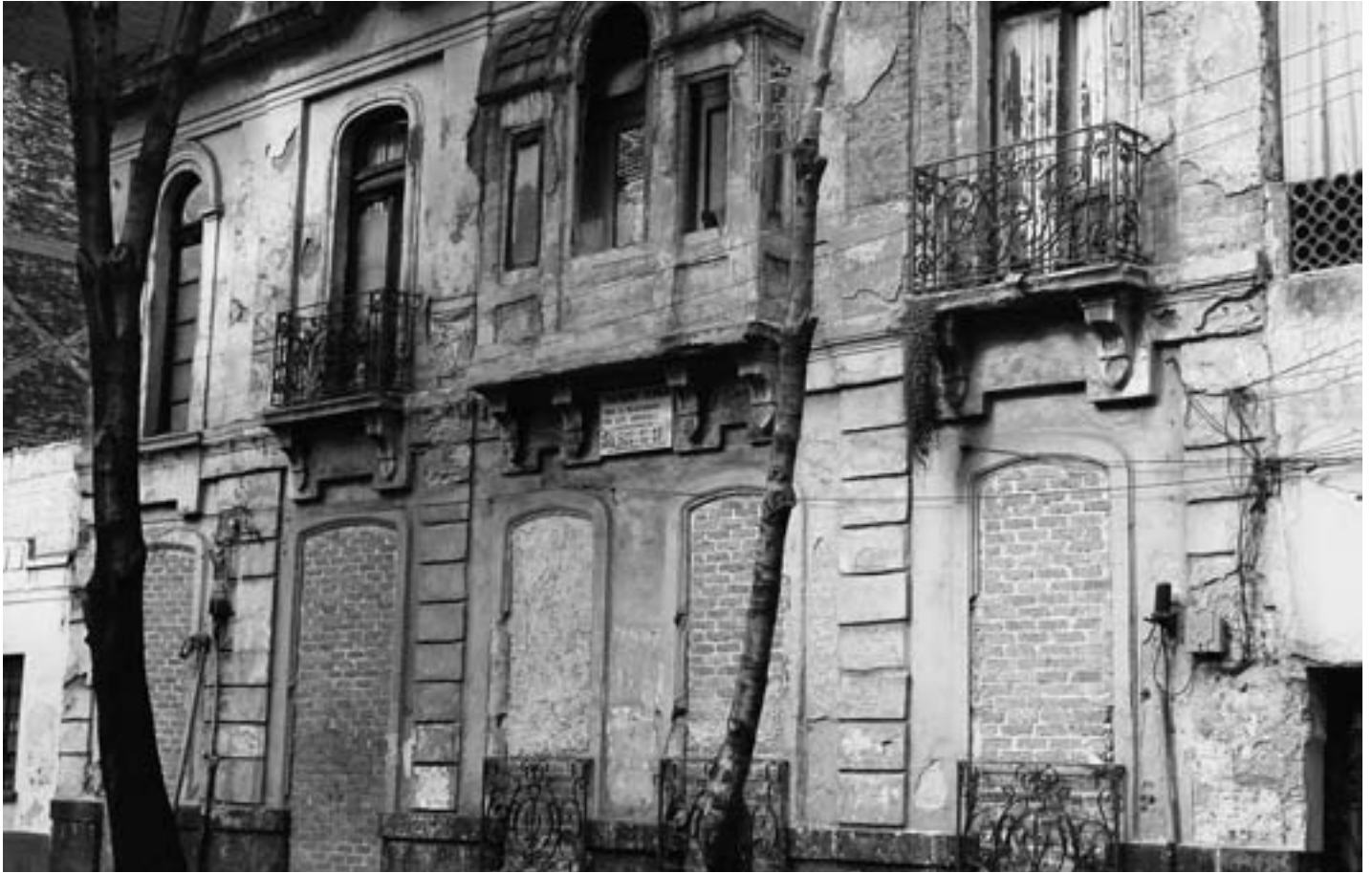
Figura 9.- Casa en ruinas. Sólo queda la fachada en pie. Foto: G. Boils, 2006.
