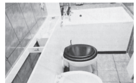
Figura 12. Pared equipada por tres lados montada sobre el piso y acabados ya terminados.
