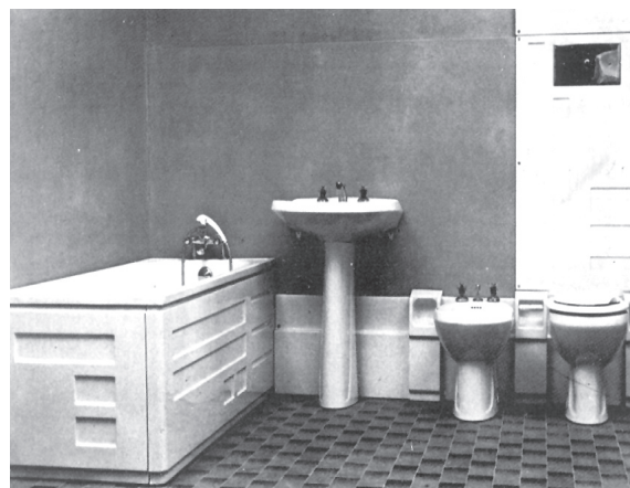
Figura 10. Colocación del módulo vertical y clausura del panel con los módulos prefabricados.
