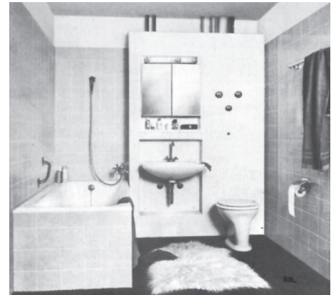
Figura 11. Pared técnica equipada en acero, de producción alemana con una altura estándar.
