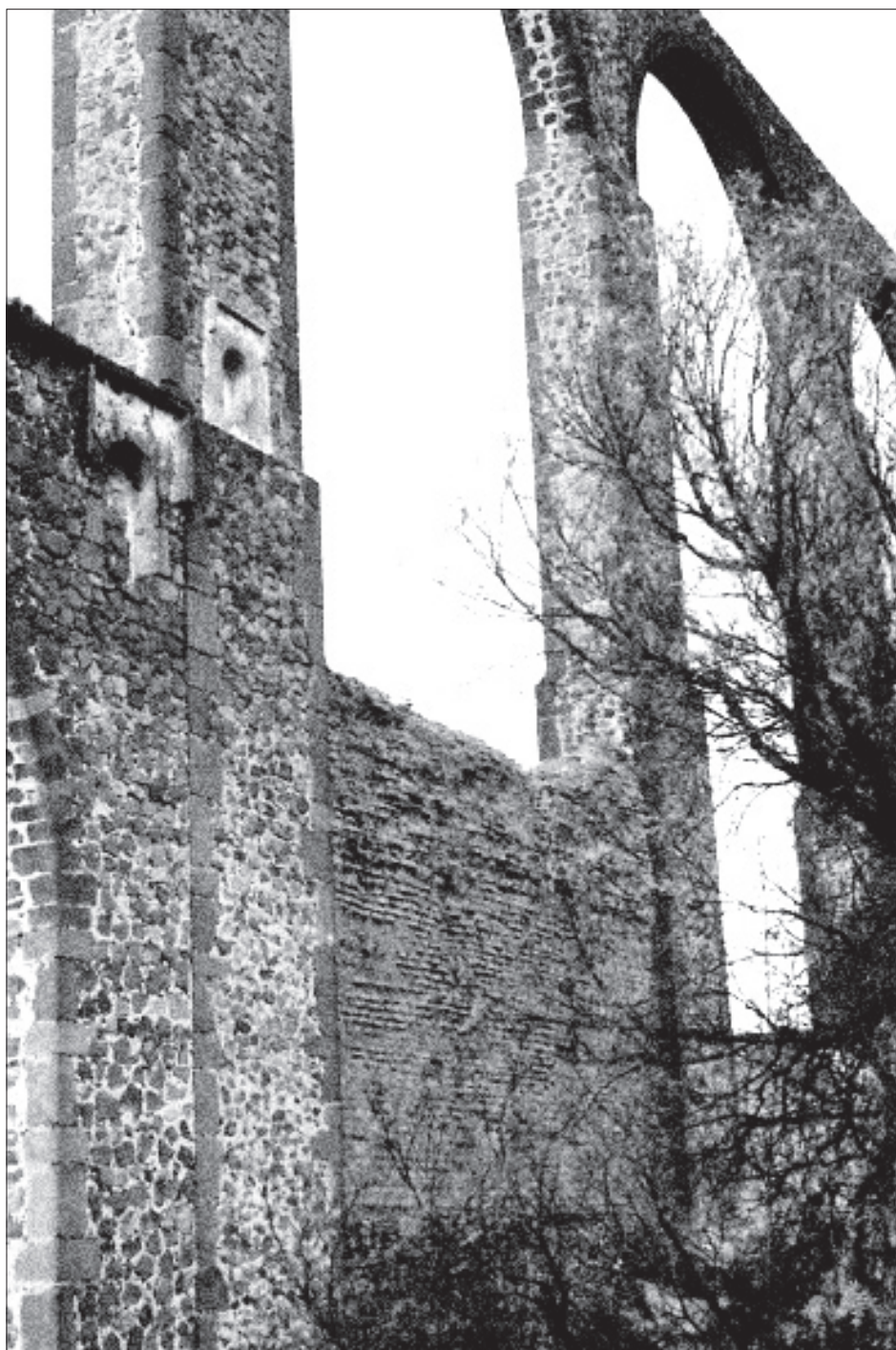
Lámina 7. Perfil de los arcos de Tepicahualco en los que se observan las secciones de diversa magnitud que presentan las columnas para dar solidez a la obra.
