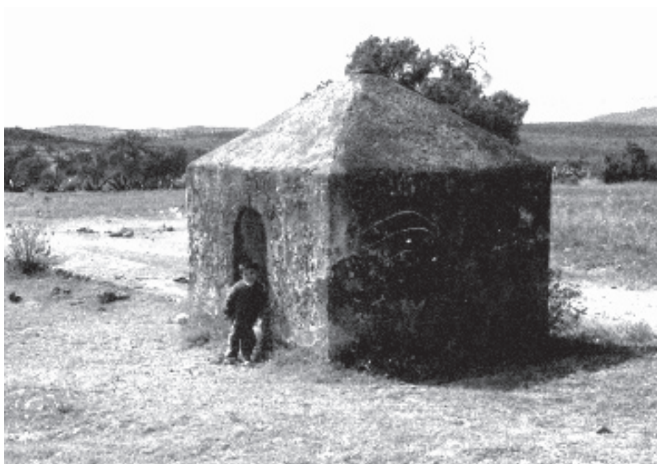
Lámina 6. Acometida al inicio de la arquería de Tepeyahualco.
