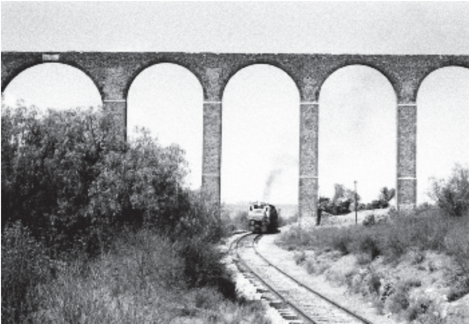
Lámina 8. Los arcos más grandes de Tepeyahualco, al extremo izquierdo el arco más grande (con 39 m de altura cubre un claro de 17 m); al centro, por el que pasa la vía ferroviaria.
