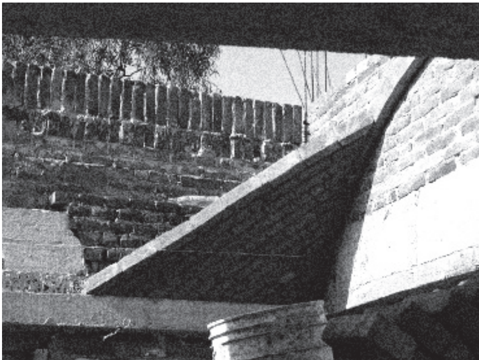
Casa Girolita , proceso constructivo inicial de las bóvedas.
