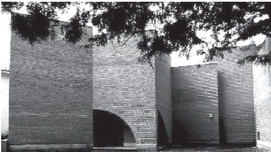
Casa Juaro, fachada norte.
