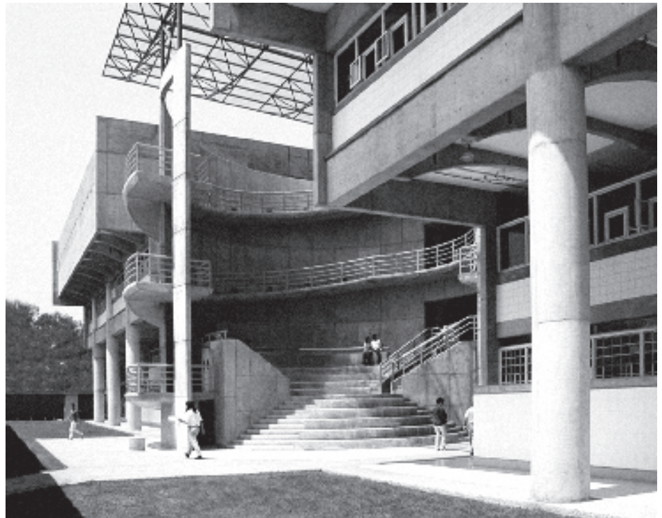
Edificio 34 UAM-Xochimilco, vista del vestíbulo, rampa y escaleras.
