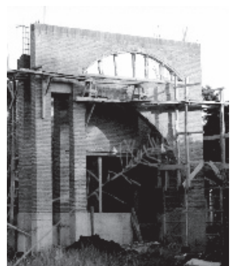
Casa Girolita , proceso constructivo de los arcos.
