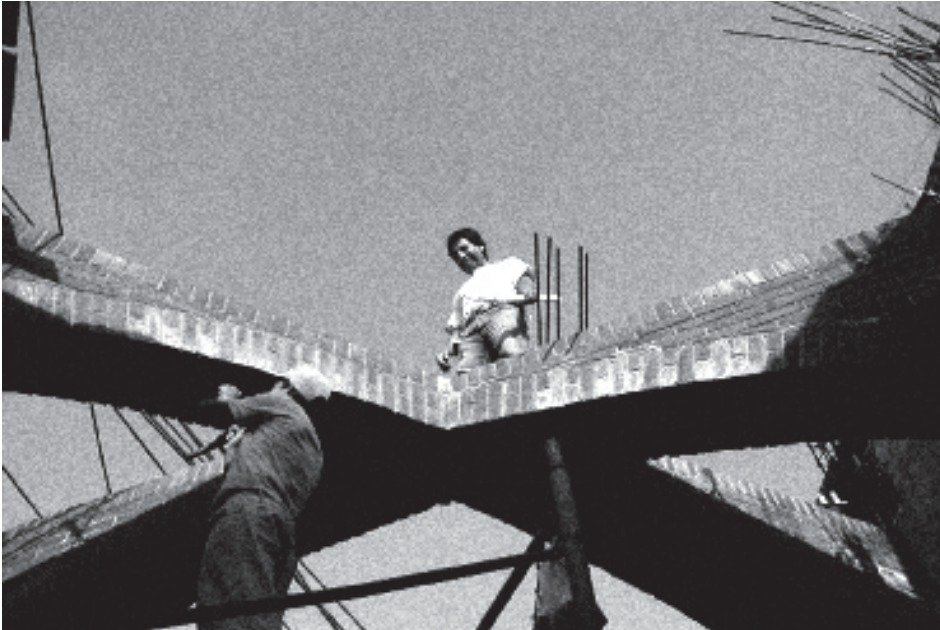
Casa Girolita , proceso constructivo de los arcos de la terraza.
