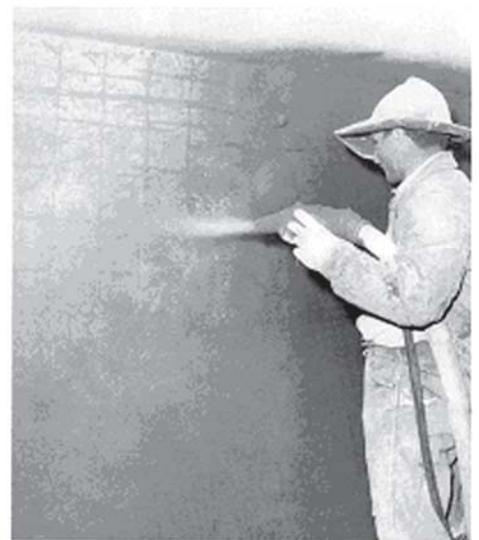
cemento y arena (3.1.2) aplicado con un pulverizador de aire comprimido (fig. 2), que ejercita una verdadera acción de martilleo sobre la superficie que se debe revestir y sobre el estrato de mortero ya aplicado, con el resultado de formar una plancha compacta, de alta resistencia y adherente a la mampostería, sin soluciones de continuidad (Baglioni, Guarnerio, 1988, 91).
