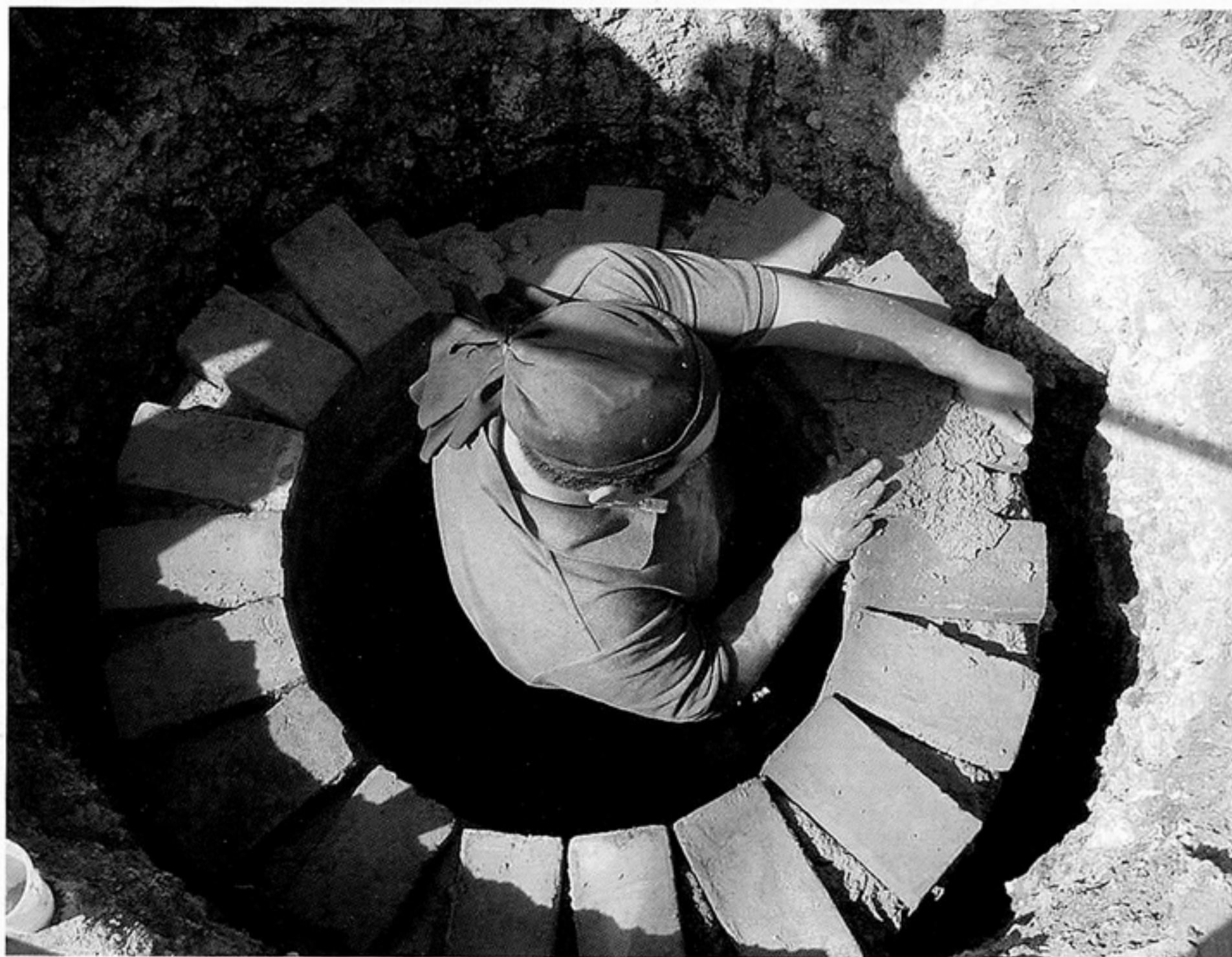
Renivelación de pozo de visita ante los eventuales derrumbes. Fotografía: Rodrigo Atilano.
