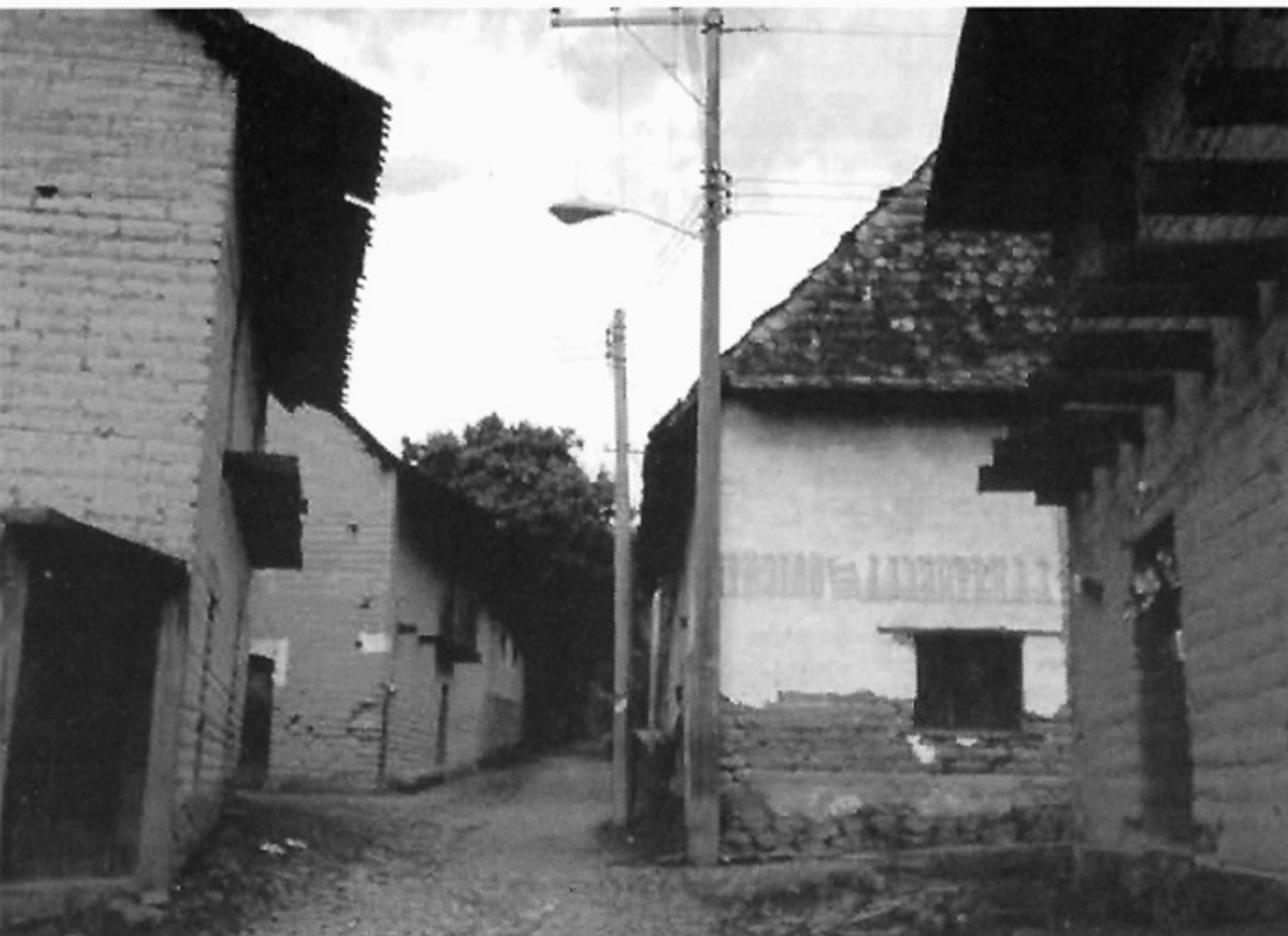
Construcciones de adobe en Hueyapan, Morelos. (fotografía: Salvador Díaz-Berrio)
