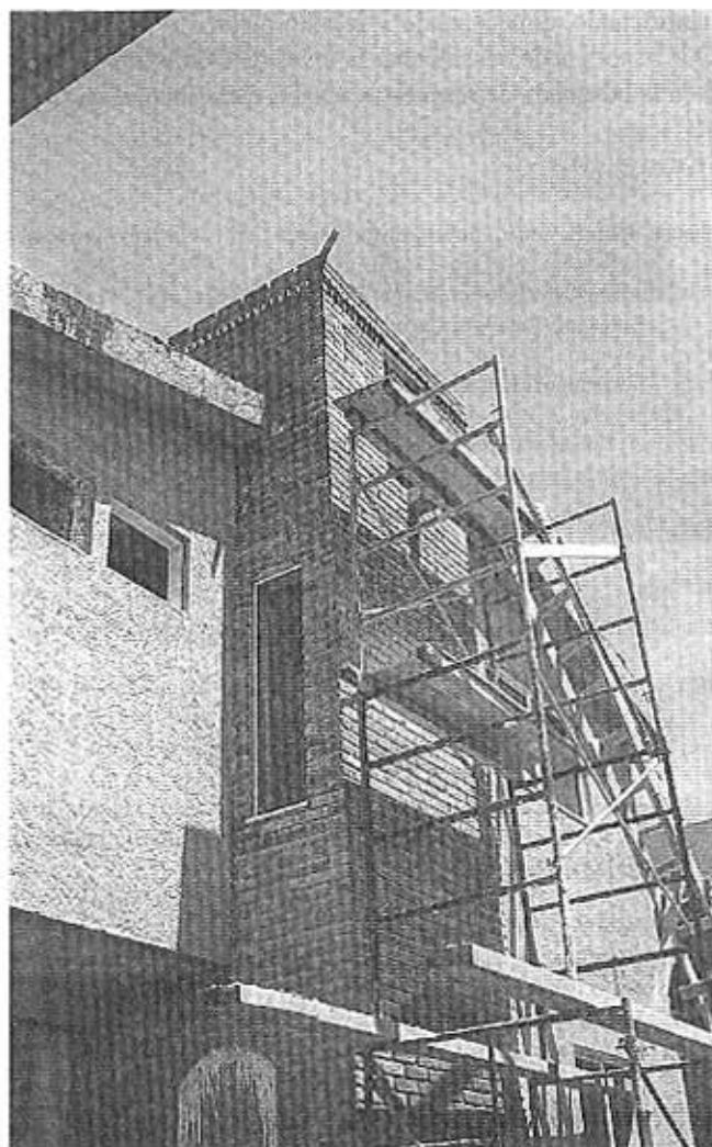
Vivienda bioclimática construida con sistema alternativo.
